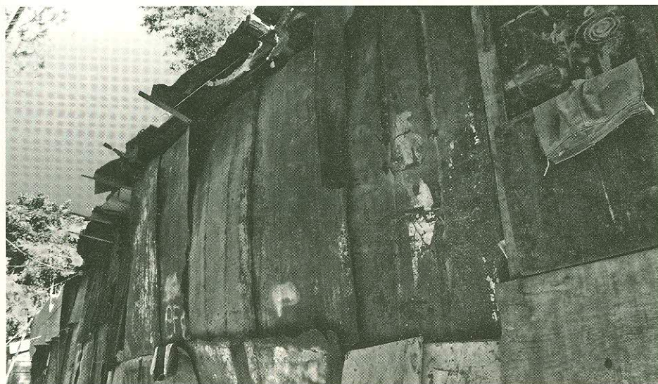
Figura 2 VIVIENDAS CON PAREDES DE LÁMINA
