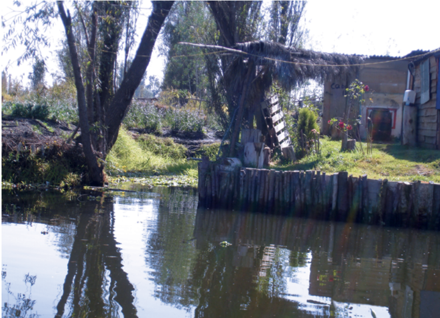
Fig. 11: Vivienda en uno de los canales de Xochimilco construida con materiales precarios en paredes y techo.
