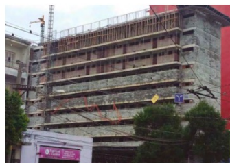
FIGURA 3 | Foto obra Fonte: RODRIGUES, E. L.; TERRA, M. de J.; MIRON, R.; VALERIO, W. de S., 2019 184 p. 51.
