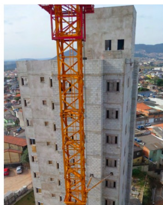
FIGURA 3 | Foto obra Fonte: Página Facebook Assessoria técnica Ambiente Arquitetura, 2019. 12
