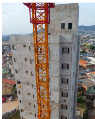
FIGURA 3 | Foto obra Fonte: Página Facebook Assessoria técnica Ambiente Arquitetura, 2019. 12
