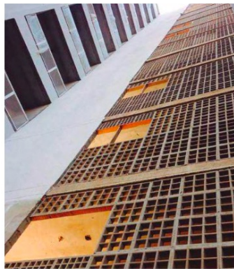
FIGURA 3 | Foto obra Fonte: RODRIGUES, E. L.; TERRA, M. de J.; MIRO N, R.; VALERIO, W. de S., 2019 44 p. 56
