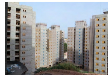
FIGURA 10 | Foto obra Fonte: Página Facebook Assessoria técnica Ambiente Arquitetura, 2019. 17
