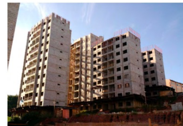
FIGURA 9 | Foto obra Fonte: Página Facebook Assessoria técnica Ambiente Arquitetura, 2015. 16
