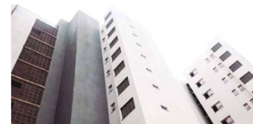
FIGURA 9 | Foto obra Fonte: RODRIGUES, E. L.; TERRA, M. de J.; MIRO N, R.; VALERIO, W. de S., 2019 44 p. 59
